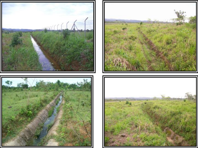
Los canales de aguas lluvias durante la inspección se encuentran en regulares condiciones de mantenimientos.
